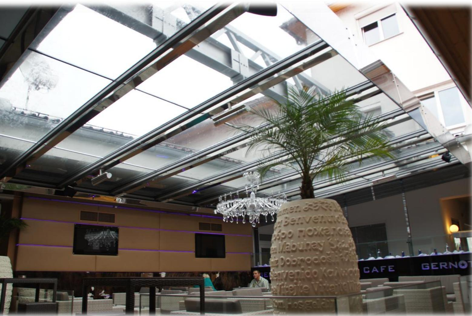
Stahlkonstruktion verzinkt und beschichtet, innen mit Spiegelblech verkleidet. Bedachung und Attika wurde als Glas ESG Parsol Grau ausgeführt!
