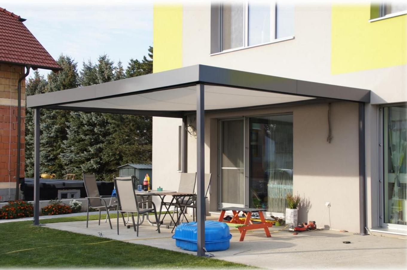
Terrassendach Stahl verzinkt und beschichtet in RAL 7016 mit VSG Sicherheitsglas aus 2x6mm TVG Scheiben. Der gültigen Norm entsprechend.
