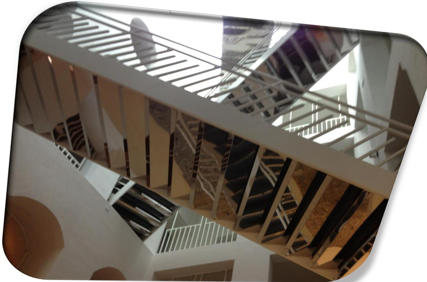
Voll verdreht sind diese Stahlstiegen, Stahlwangen aus 25 mm Stahl lackiert, mit einem Geländer aus 25x25mm Vollstab Material. Auf der Stiegen Unterseite wurden Spiegelbleche montiert. Der Effekt ist atemberaubend!
